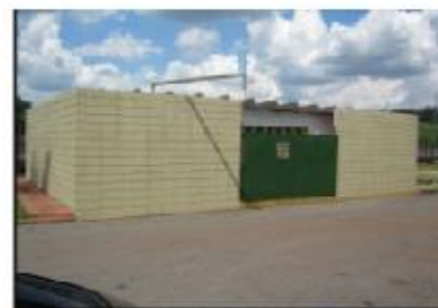
1 - EDIFICAÇÃO DA ESTAÇÃO ELEVATÓRIA DE ÁGUA BRUTA DO ESM
