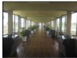
10 - INTERIOR DA SALA DE MANOBRA DOS FILTROS
