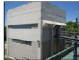
14 · DEPÓSITO DE PRODUTOS QUÍMICOS
