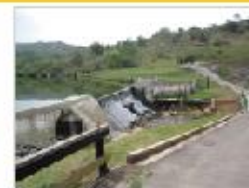
3 - VISÃO VENDO DE UM PONTO DE VISTA, PARA O RIO, BORDO DA PAREDE
