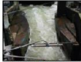
5 - DETALHE DO MEDIDOR PARSHALL NA CHEGADA DE ÁGUA BRUTA.
