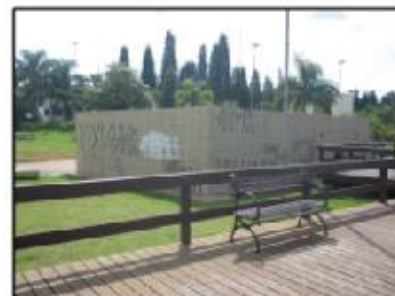
3 - OUTRA VISTA DA EDIFICAÇÃO
