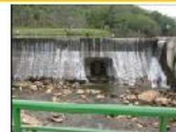
4 - DETALHE DE DESCARGA DE FUNDO DA PAREDE
