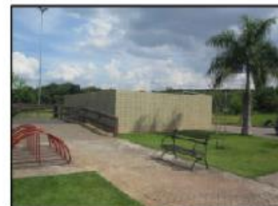
4 - OUTRA VISTA DA EDIFICAÇÃO
