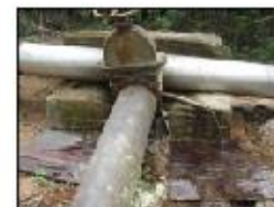
12 - VISÃO DA PAREDE DE DRENAGEM DE ÁGUA
