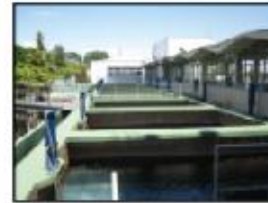
18 - VISUAIS FILTROS LOCALIZADOS ATRÁS DA SALA DE MANOERA.
