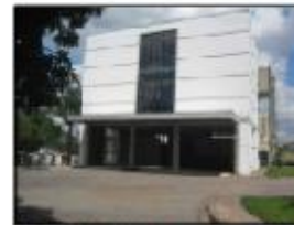
ET VISTA DA UNIDADE DE CONDICIONAMENTO DA ET
