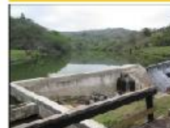
2 - VISTA DA PAREDE
