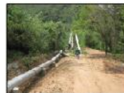
10 - VISTA DA PAREDE DA BARRAGEM E SUPORTE
