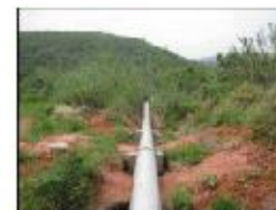
8 - VISTA DE UMA DAS ADUTORAS, COM O TUBO DE DRENAGEM DE ÁGUA
